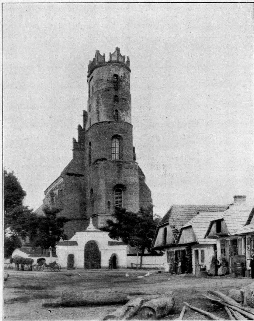
KOŚCIÓŁ W CHODLU PRZED OSTATNIĄ PRZEBUDOWĄ. „Fot. ze zbiorów Pol. Tow. Krajozn.
