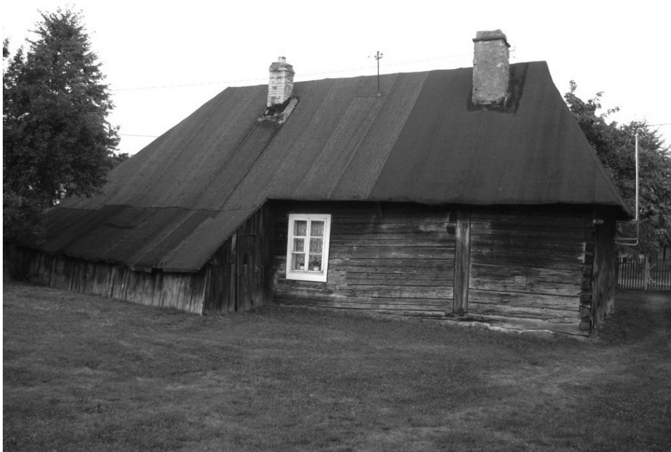
Obiekt od strony zachodniej
