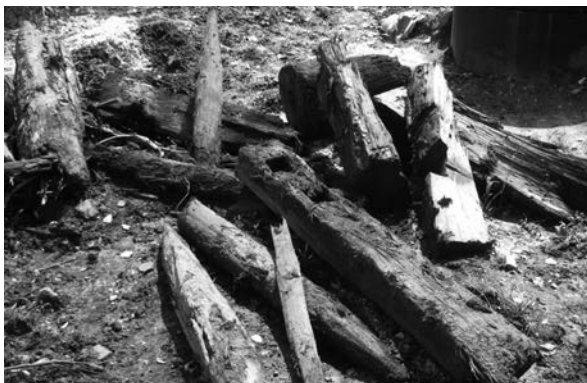
Elementy drewnianej konstrukcji. Fot. autor
