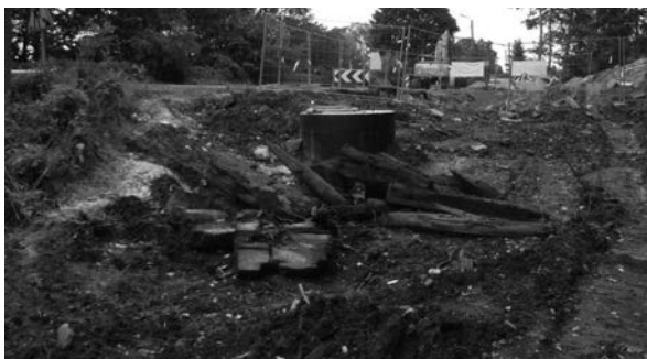
Wydobyte fragmenty zabytkowej konstrukcji złożone przy placu budowy. Fot. autor
