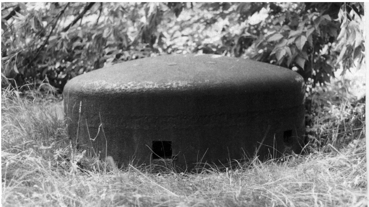
Pancerna kopuła obserwacyjna produkcji Zakładów Ostrowieckich, wmontowana w 1935 r. w jednym z fortów Twierdzy Modlin. Zbiory autora.
