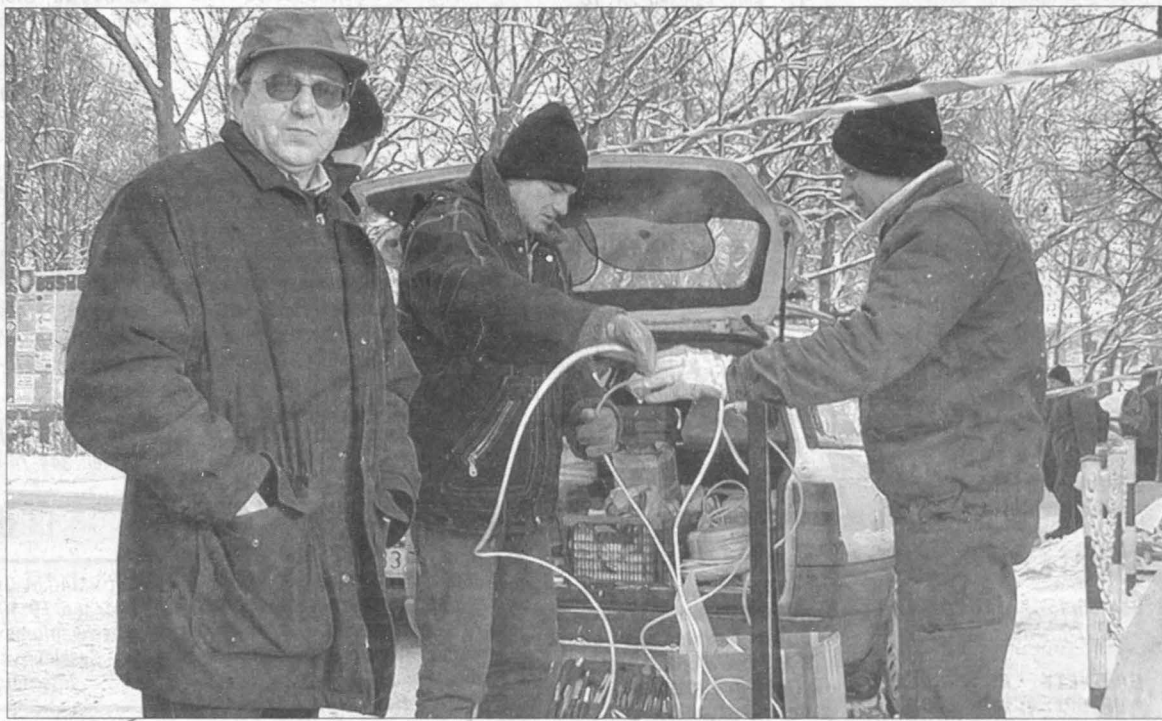
Tarnobrzescy fachowcy z firmy Mator rozpoczęli instalowanie kamer od budynku starej poczty. Z lewej szef ekipy Zbigniew Marciniak
