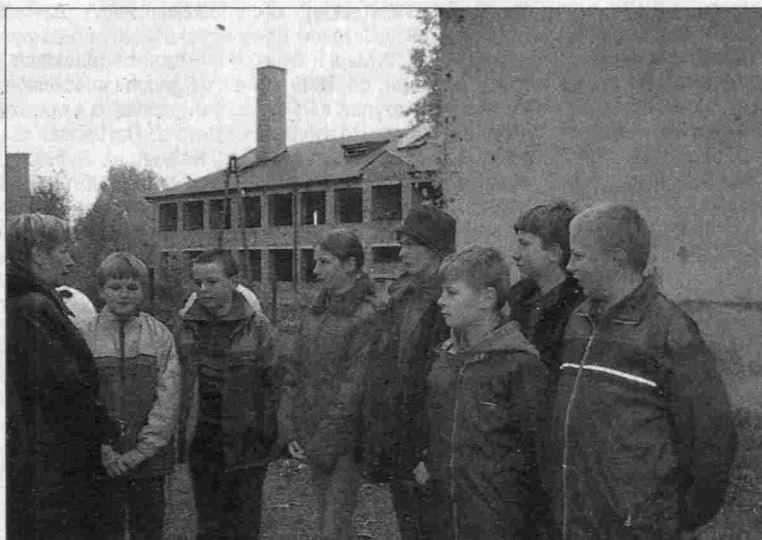
Dyrektor Lidia Radomska rozmawia przy starym budynku szkoły z uczniami szóstej klasy. W oddali nowy budynek szkoły w stanie surowym
