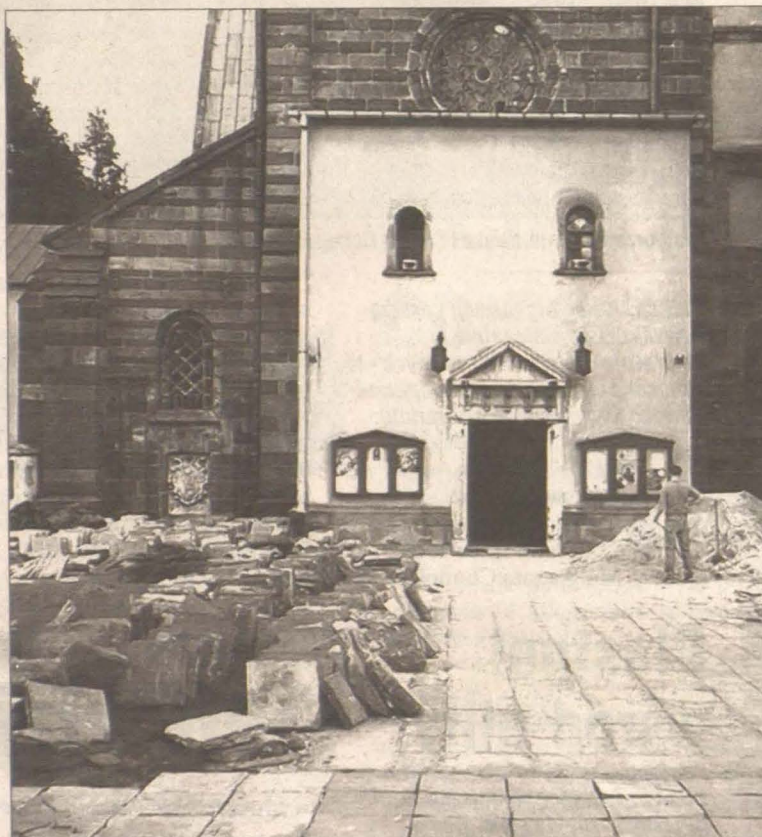
Prace przy wymianie posadzki zakończą się w czerwcu
