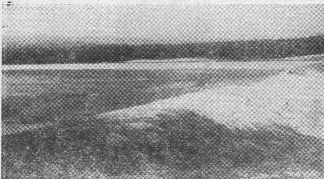
Widok na zbudowane już wały zbiornika.
