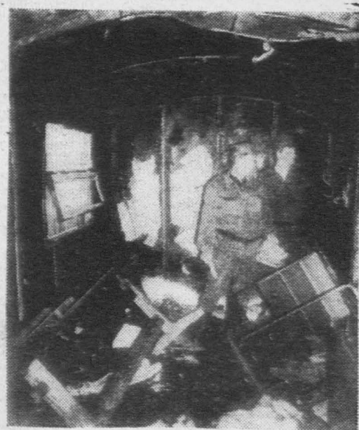
Dość mocno spalony barakowóz na placu rozbudowy szpitala dziecięcego w Kielcach. Fot. Al. Piekarski
