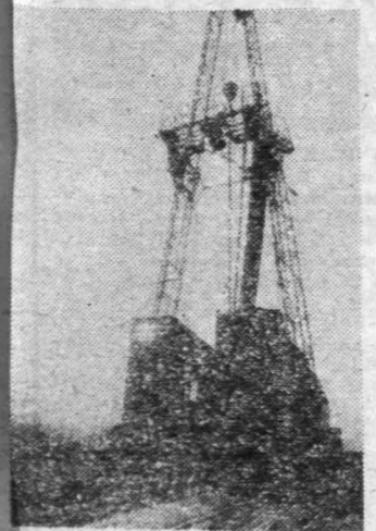
To urządzenie wywierci otwór o głębokości 800 metrów.
