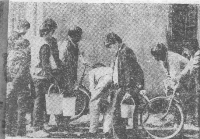
W tym roku nawet przy ulicznych pompach było spokojnie...
