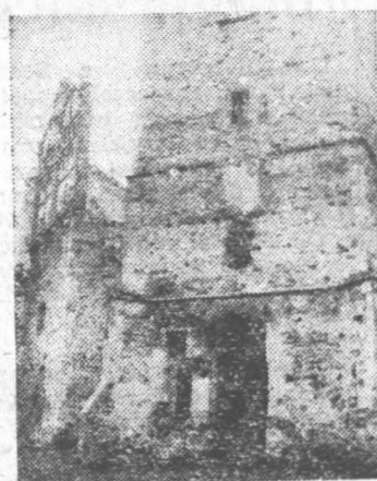
Wieża z bramą —jazdową w Drzewicy.
