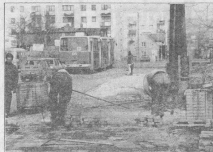
Wymiana płyt chodnikowych na ulicy Piecka (robotnicy przy pracy). Fot. A. Pietras
