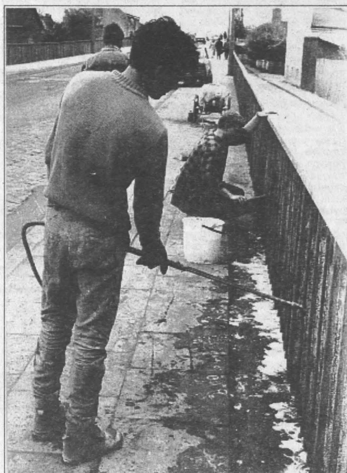
Trwa malowanie barierki wiaduktu na ul. 1 Maja w Kielcach. Kierowcy cenią sobie estetykę, ale z większą niecierpliwością oczekują ułożenia nowej nawierzchni. Przednia zlaża z mostu natychmiast po długotrwałym remoncie.
