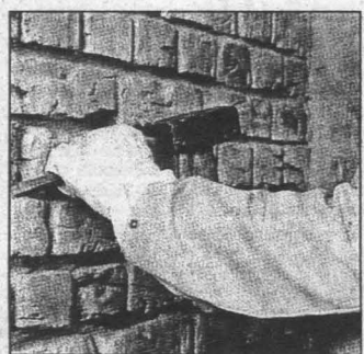
Najpierw oczyszczamy ścianę i spoiny.
