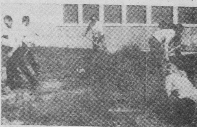
Grupa pracowników administracyjno-biurewych przy pracach remontowych, wykonywanych na terenie zakładu w ramach czynu społecznego.
