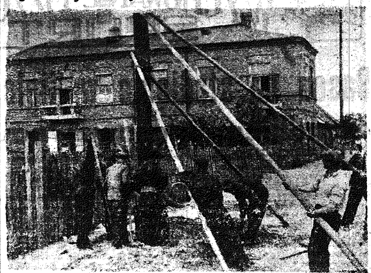
Nawet ciężki i wysoki słup telegraficzny nie oprze się wspólnemu wysiłkowi robotników ZEORK-u, którzy uzupełniają linię oświetleniową nowymi słupami.
