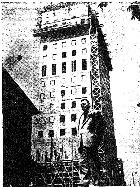
Pomysł, który zaoszczędził ponad 5.4. pół miliona zł. Inż. Stefan Bromke, kierownik budowy wieżowca Młn. Kom. w Warszawie zaprojektował do prac przy montażu okładki kamiennej elewacji, wstępcze rusztowanie stalowe. Lekkie, oalkowicie bezpieczne, wygodne do pracy rusztowanie pozwoliło zaoszczędzić na budowie wieżowca 5.565.286 zł na tak cennym materiale, jakim jest drewno. Na zdjęciu: inż. Bromke na 16 wieżowca; przy 13 piętrze widoczne nowe rusztowanie.
