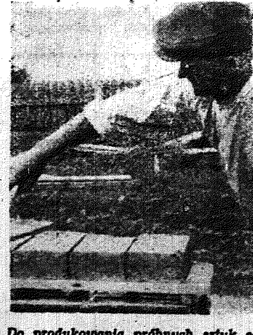
Do produkowania próbnich sztuk cegły trocinowo-wapiennej wystarczy tak oto „maszyna”. Dachowca A. Gruska formuje na niej dziennie około 200 sztuk cegieł.
