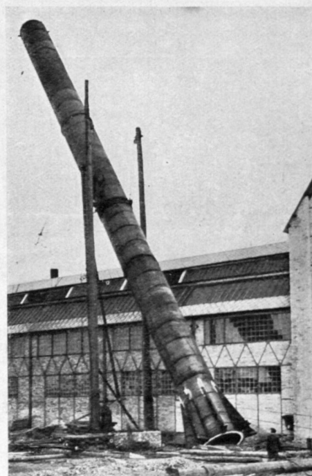
Komin blaszany wolnostojący o wysokości 41 m i średnicy 2,5 m spawany z blach grubości od 8 do 6 mm. Cheminée indépendante en tôle 41 m. de hauteur, \Phi 2,5 m, soudée en tôle de 8 à 6 mm. d'épaisseur Isolated chimney, 41 meters high and 2.5 meters diameter, welded of sheet iron of 6 to 8 mm. thickness. Freistehender Schornstein von 41 m Höhe und 2,5 m Durchmesser aus 8–6 mm. starkem Blech zusammengeschweisst.
