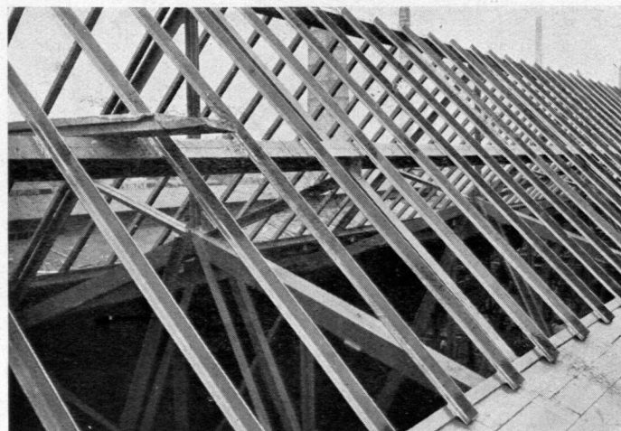
Świetlnia hali maszyn Lanterne de la halle de machines Skylight of machine shop Oberlicht der Maschinenhalle
