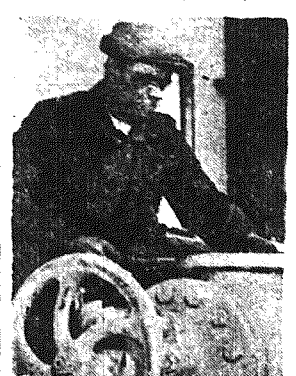
Szybko postępuje naprzód praca przy budowie największej w Polsce elektrowni w Dychowie. Na zdjęciu: Słuszarczyk Adam pracuje przy pasowaniu kolumny zaworów olejowych. (CAF fot. Baranowski)
