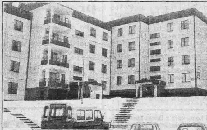
Trzy piętrowy blok w osiedlu im. J. Kochanowskiego w Kielcach
