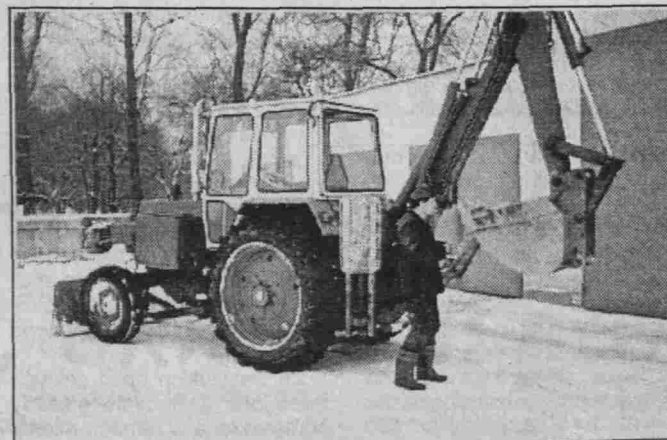
By usuwać awarie wodociągowe, koparka musi być sprawna... Na placu ZGK w Miechowie Fot. Z. Wojtiuk
