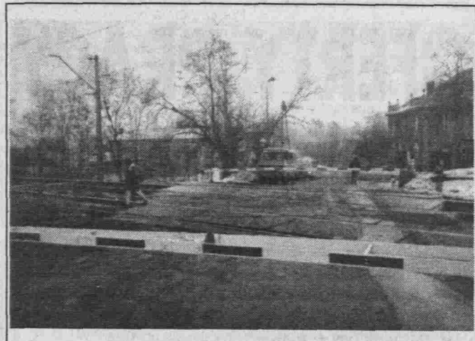
„Garbaty” przejazd PKP w Charsznicy
